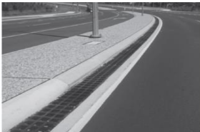
Figure 6 Longitudinal Ditch
